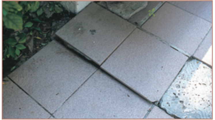
شكل 2-2 يبرز البلاط نتيجة نقص فجوات التمدد
