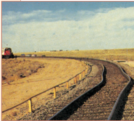
شكل 2-3 قضبان حديدية مشوهة لعدم وجود فجوات كافية للتمدد
