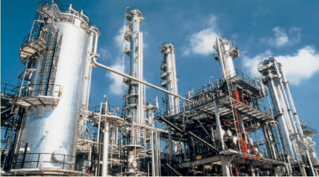
النفط مخلوط مركب من الهيدروكربونات، تفصل إلى أجزاء مفيدة داخل أعمدة تجزئة عملاقة في معمل تكرير النفط.
